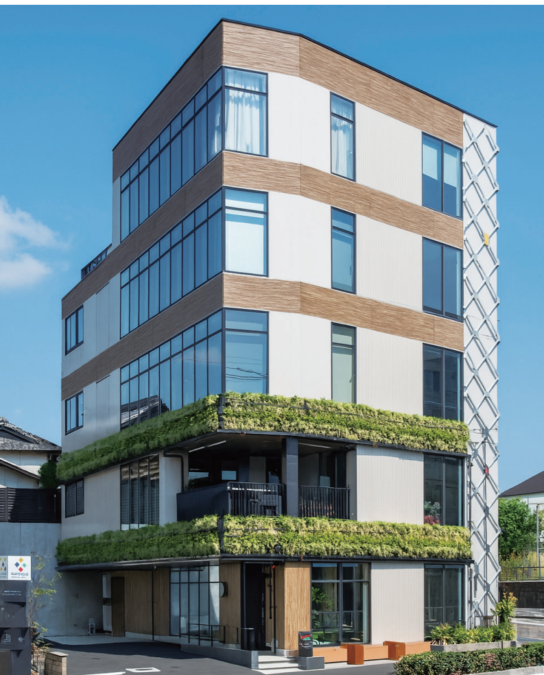
Photo / RUBIQUE SQUARE 新築工事 施工: 杉本組
