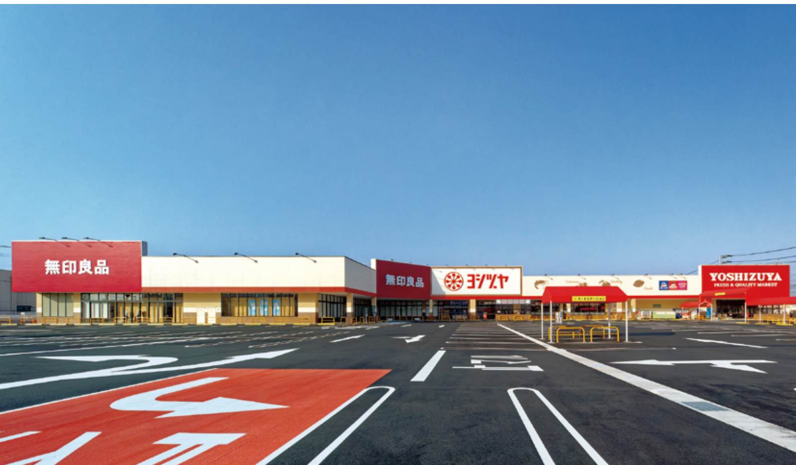
Photo／ヨシツヤYストア笠松店 新築工事 施工：杉本組
