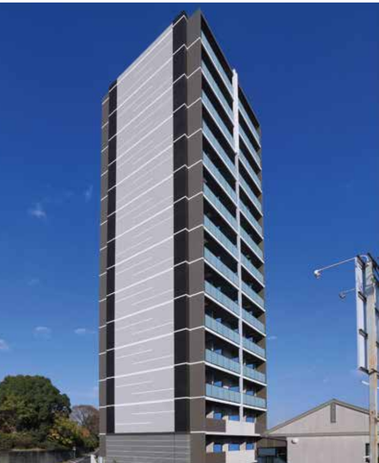
Photo(左) / S-RESIDENCE 庄内通 North 新築工事 施工:杉本組
