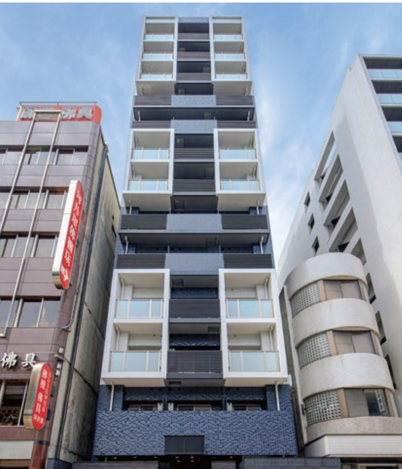
Photo(左)／プレサンス東別院駅前II 新築工事 施工：杉本組
