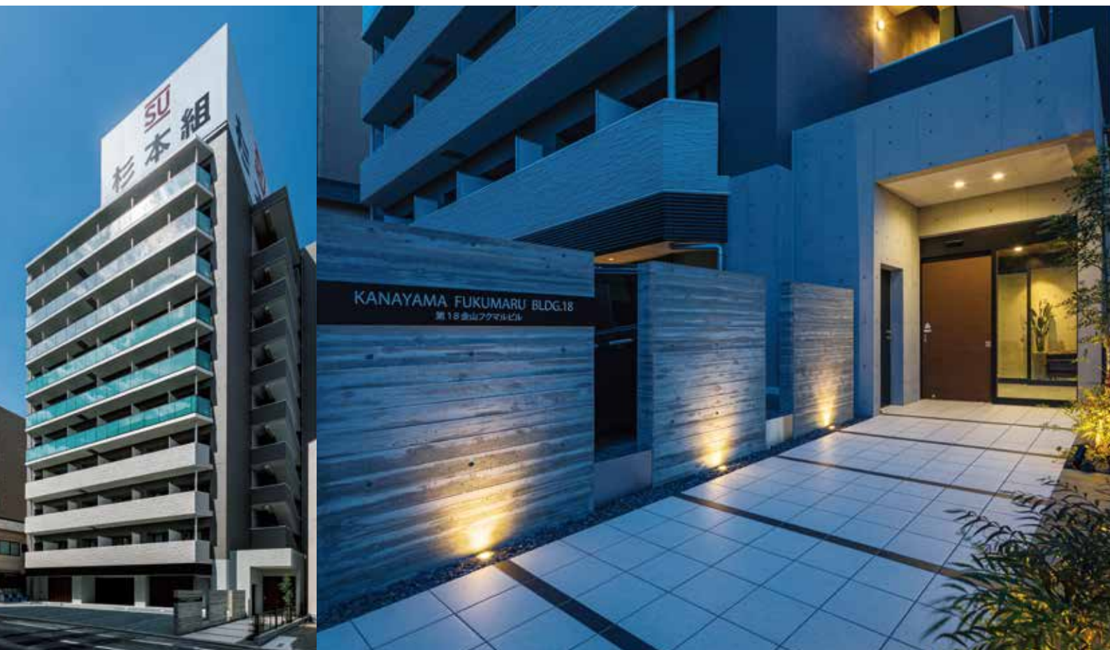
Photo／第18金山フクマルビル新築工事（設計施工：杉本組）
