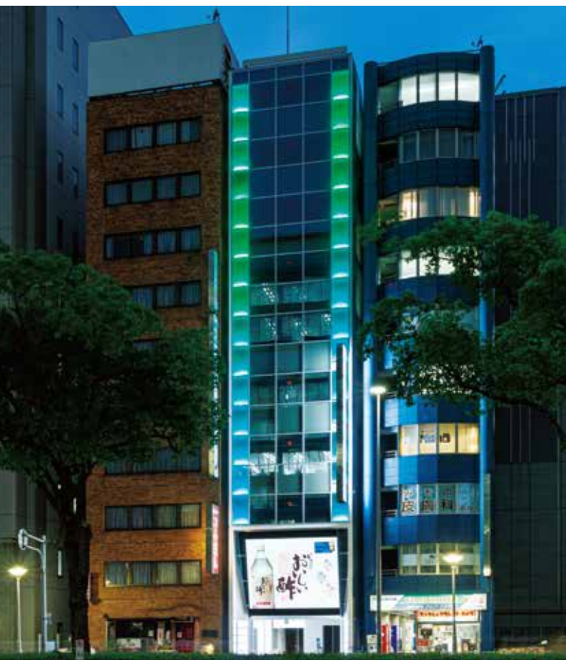
Photo/Lumiriz Fushimi(ルミライズ伏見) (施工:杉本組)
