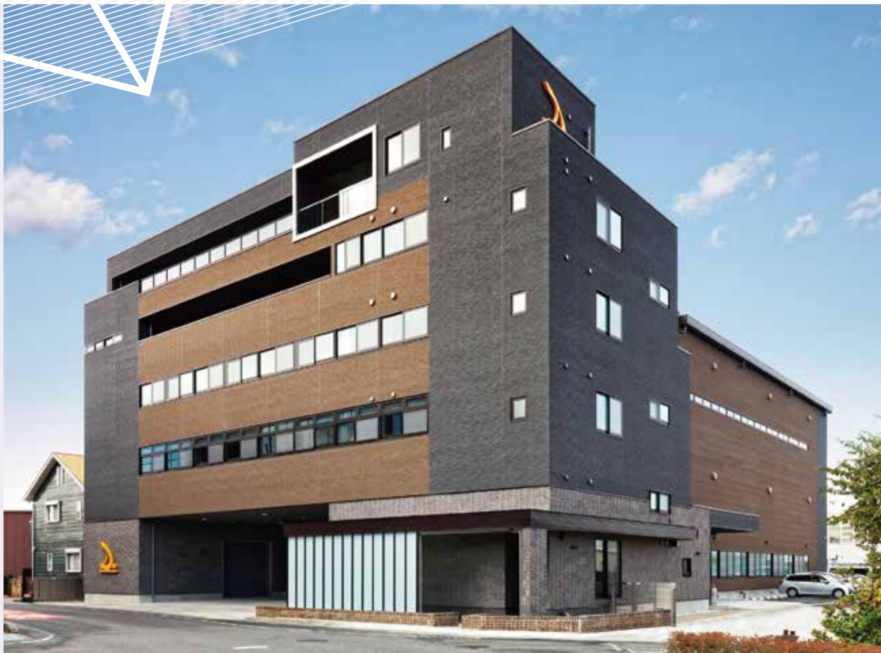
Photo/ダイサン・第5プラファ 新築工事(施工:杉本組)
