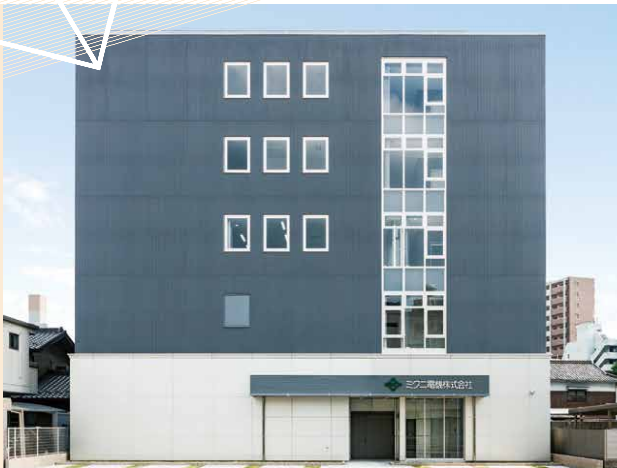
Photo/ミクニ電機社屋 新築工事(設計施工:杉本組)
