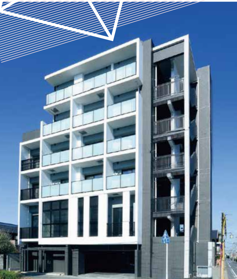
Photo/ジェプロ大江 新築工事(施工:杉本組)
