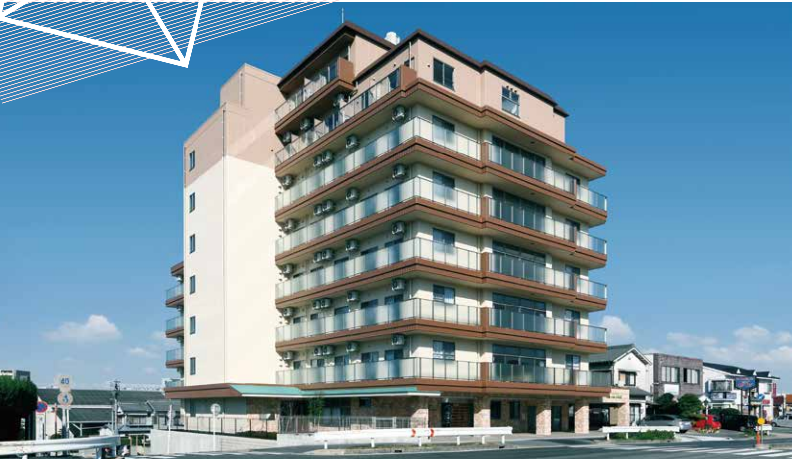
Photo/特別養護老人ホーム ケアマキス笹原(施工:杉本組)
