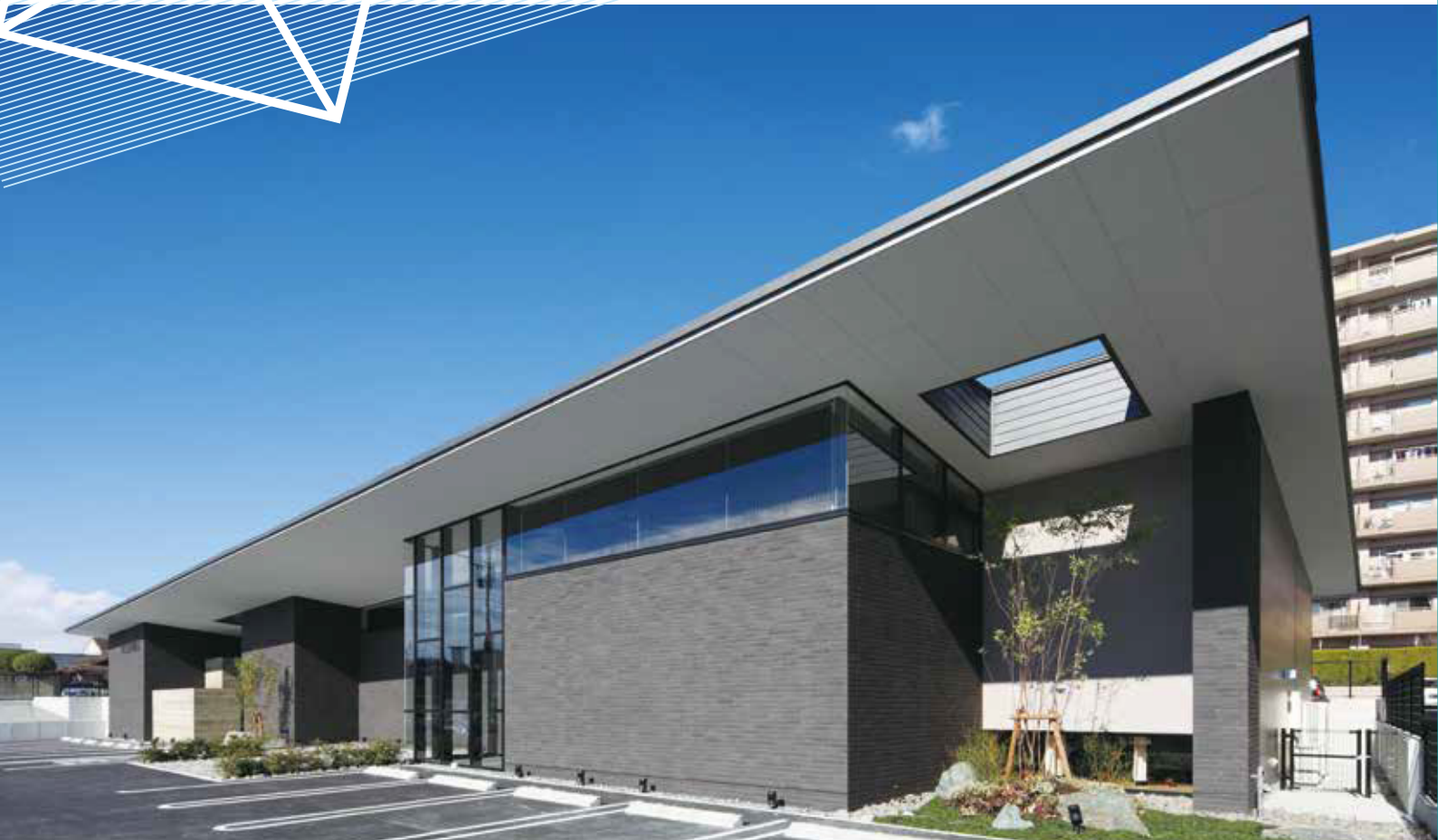
Photo／わたらい眼科新築工事(施工：杉本組)
