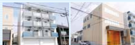
①ジュール広川 ②ジェイトレード物流センター
