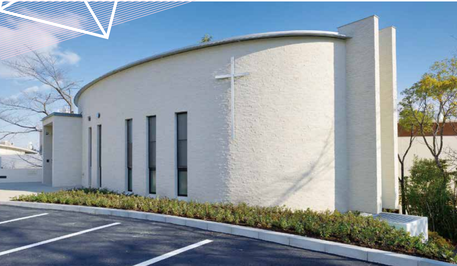
Photo/カトリック南山教会ヨセフ館(施工:杉本組)
