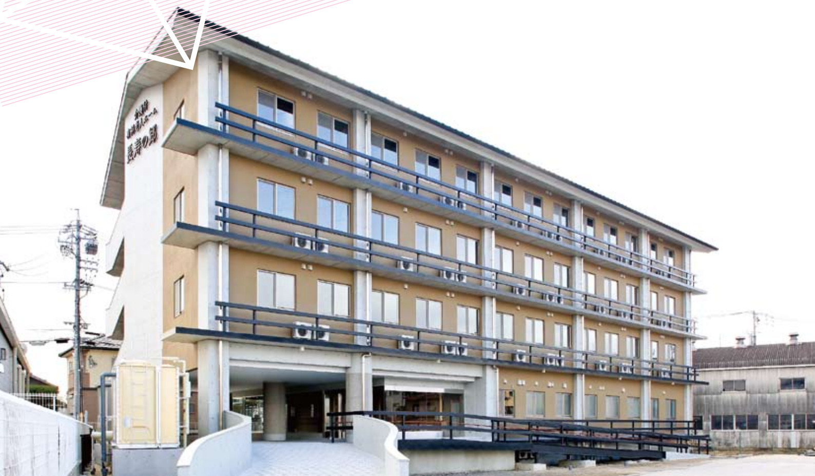
Photo/有料老人ホーム 長寿の郷(施工:杉本組)
