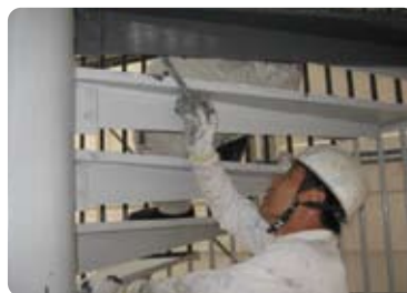
▲ 螺旋階段塗装
