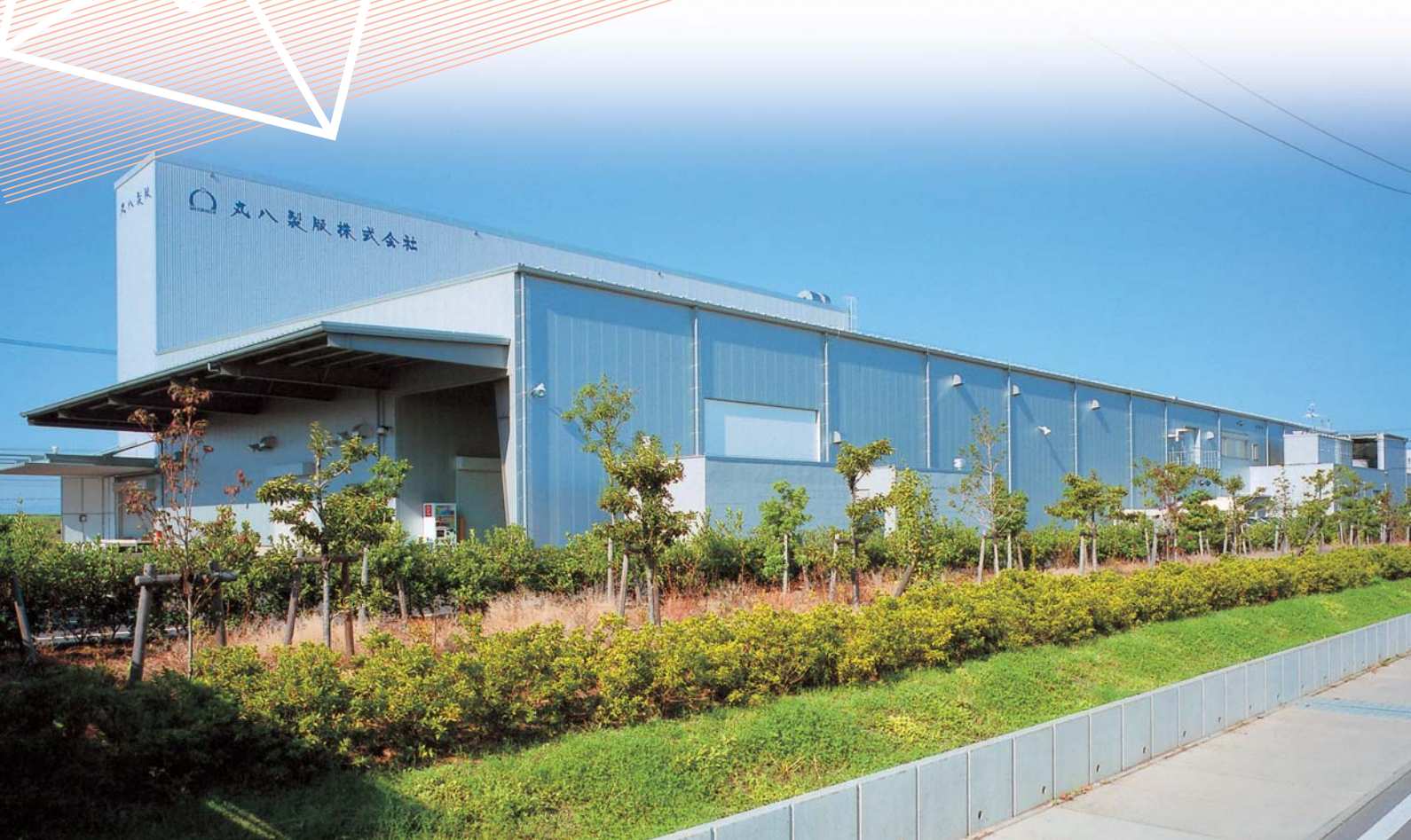
Photo / 丸八製版株式会社 (施工: 杉本組)
